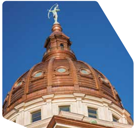
Rénovation du Kansas State Capitol (USA)
